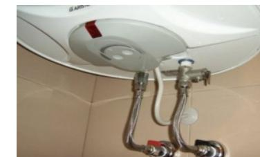
L'acqua calda sanitaria è prodotta con boiler elettrici
