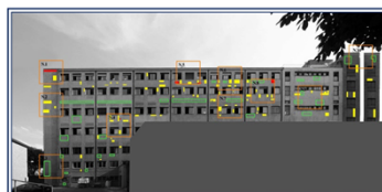
Figura 5: prospetto nord, localizzazione dei distacchi più significativi
