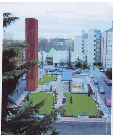
La torre per l’evacuazione del fumo e del calore prodotti dalla centrale. La struttura metallica di acciaio zincato è rivestita di pannelli in COR-TEN, acciaio ad alta resistenza e anticorrosione.
